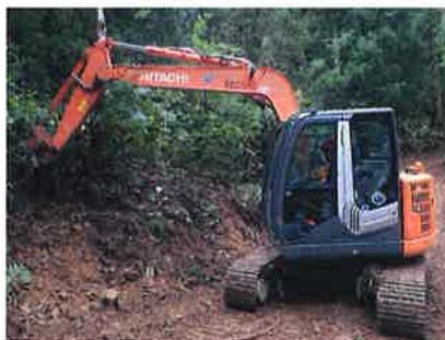
森林作業道の開設
