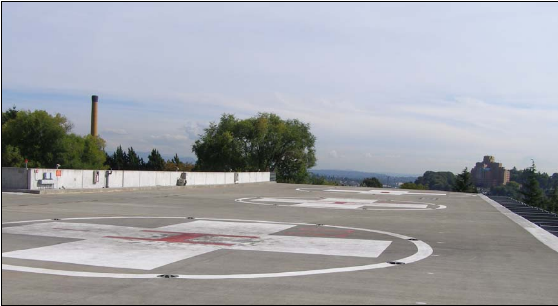
ハーバービュー病院のヘリポート——駐車ビル屋上に3面の着陸帯
